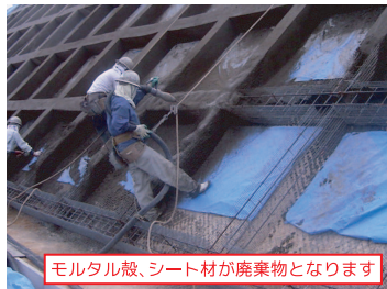
【従来工法】モルタル吹付のり枠工
