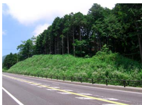
▲自然公園内の道路のり面事例(施工後4年)
