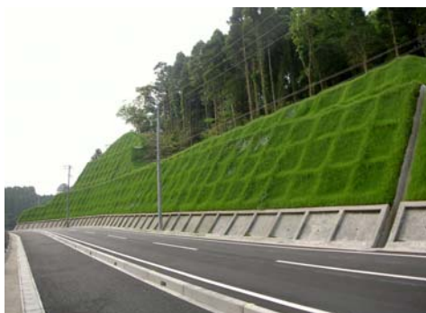
▲道路のり面での適用事例(施工後3ヶ月)
